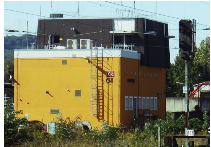
Stellwerk Gelnhausen heute
