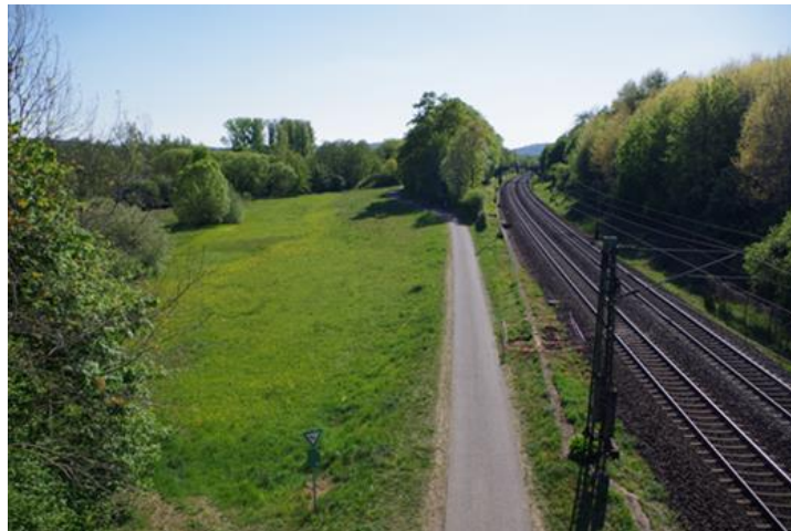
DB Bestandsstrecke im Kinzigtal Fotos: Dettmar
