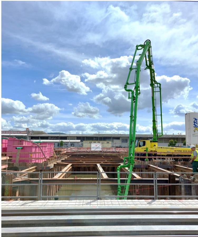
Unterwasserbetonage zur Herstellung der Betonsohle - August 2024
