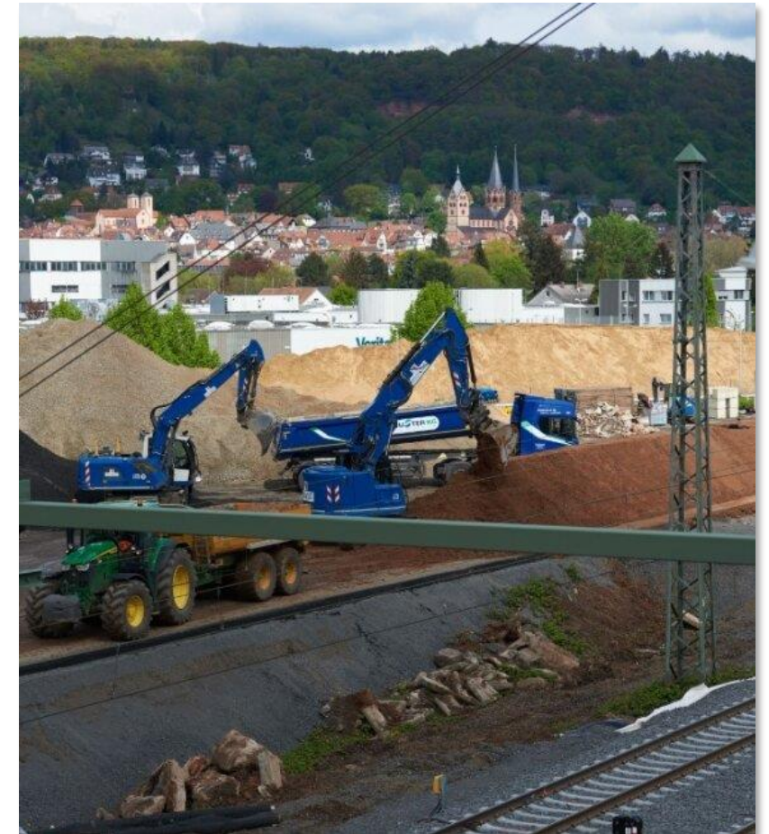
Fläche für die Zwischenlagerung von Erd- und Bodenmaterial im Gleisdreieck
