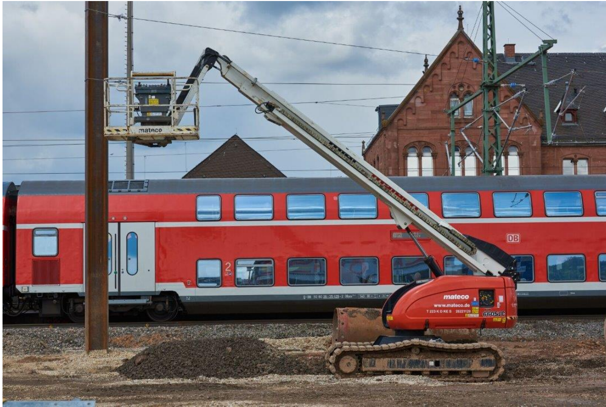
Behelfsmasten zur Abspannung der Oberleitungsanlage über die noch befahrenen Bahngleise
