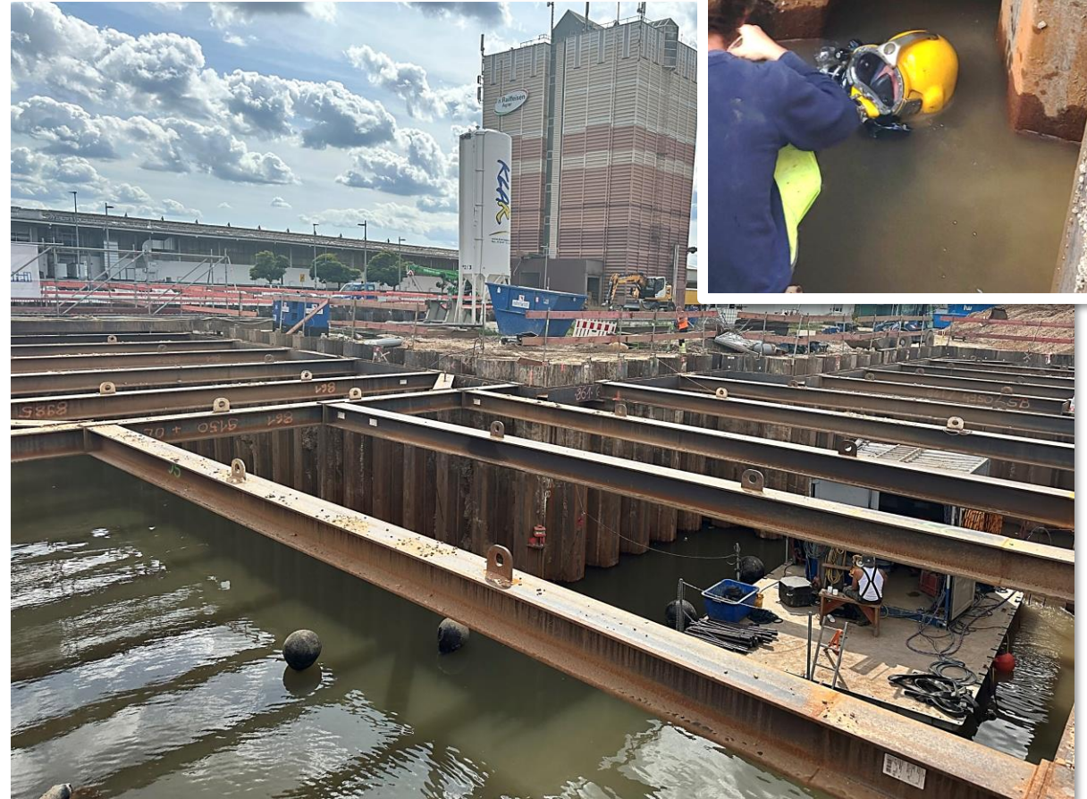
Baugrube der zukünftigen Personenunterführung mit Bautauchern, Herstellung der Ankerköpfe für spätere Unterwasserbetonage
