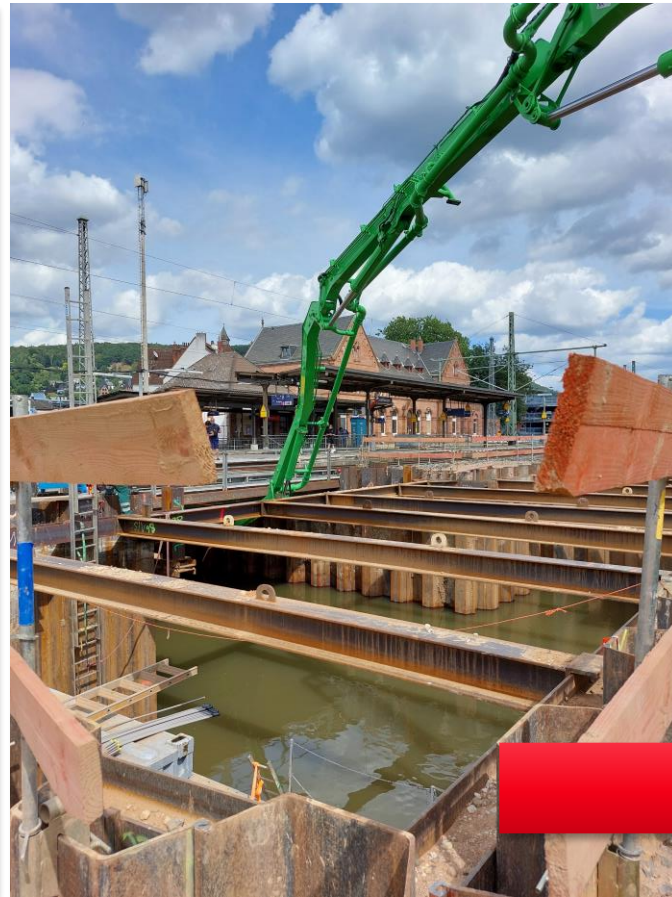
Unterwasserbetonage zur Herstellung der Betonsohle - August 2024
