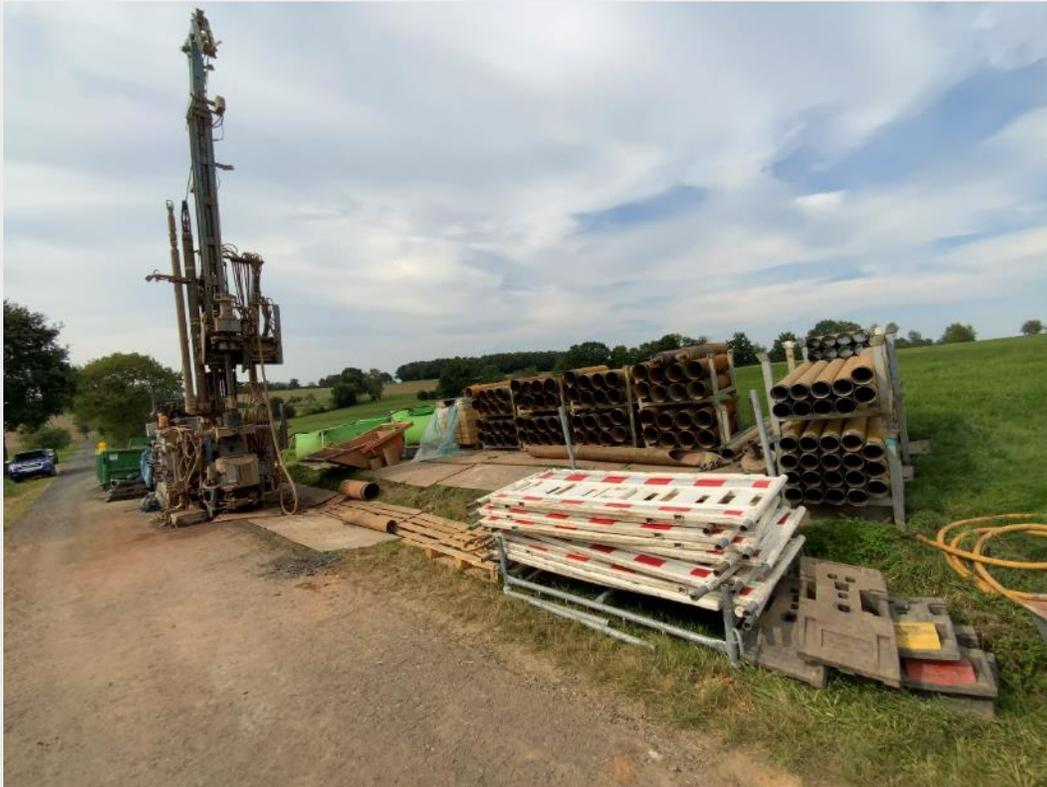
Bohrgerät und mittels durch Plastikmatten abgesicherte BE-Fläche sowie Zuwegung.
