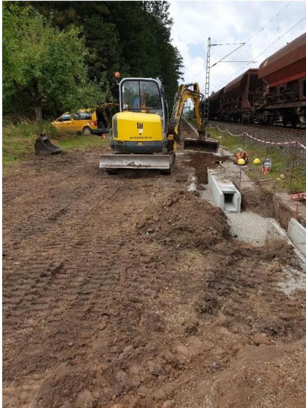
Erdarbeiten im Zuge der Arbeiten für den neuen Kabelkanal
