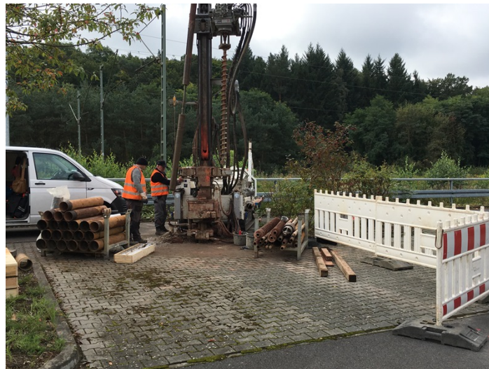
Kleinrammbohrung in Langenselbold (Bahnhof) am 19. September 2017
